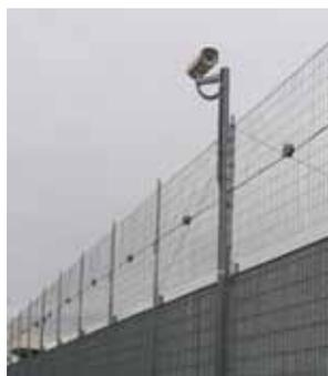
SERIR est un système de détection périmétrique par capteurs piézo dynamiques adapté aux grillages souples, panneaux soudés, et concertina. Chaque capteur est indépendant. Il détecte les chocs et vibrations de tous les types de franchissement. La localisation précise de l'intrusion permet une confirmation vidéo cadrée par caméras fixes ou motorisées. L'ensemble est nativement IP. Le système, sensible mais fiable, est insensible aux perturbations environnementales (météo, végétation, trafic).
